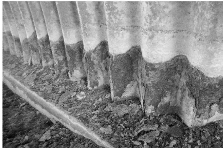
**CULVERT DEBRIS, TYPICAL**
