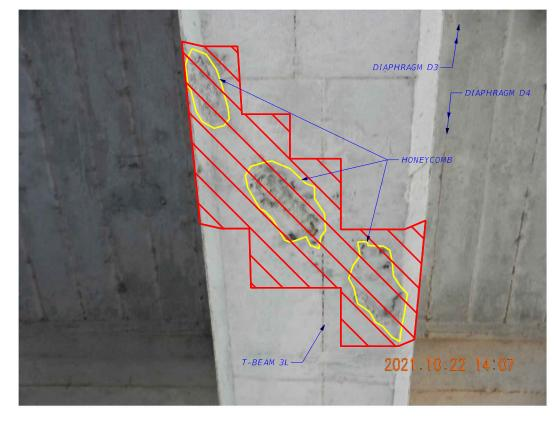
HONEYCOMB UNDERSIDE OF T-BEAM IN SPAN 3 REPAIR AS INTERMEDIATE SPALL (REF FIG 3-3, TXDOT CRM)
