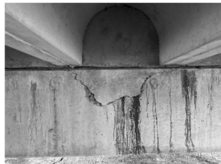
① DELAMINATION ON EAST FACE OF BENT 4 BETWEEN BEAMS 5N AND 6N
