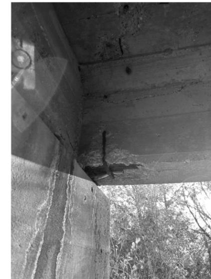
**1) REPAIR SPALL ON BEAM 1E**
