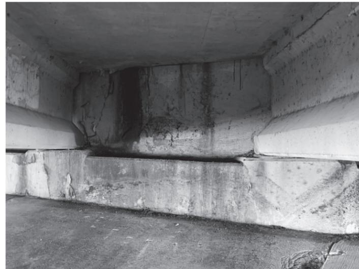
MINOR SPALL ON BACKWALL
