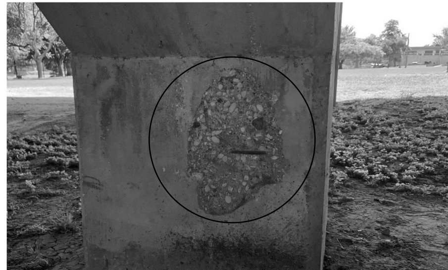
BENT CAP 1, COLUMN 2
