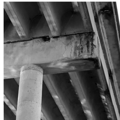
Bent Spall
