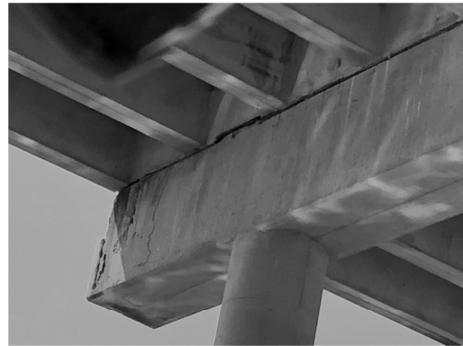
Bent Spall
