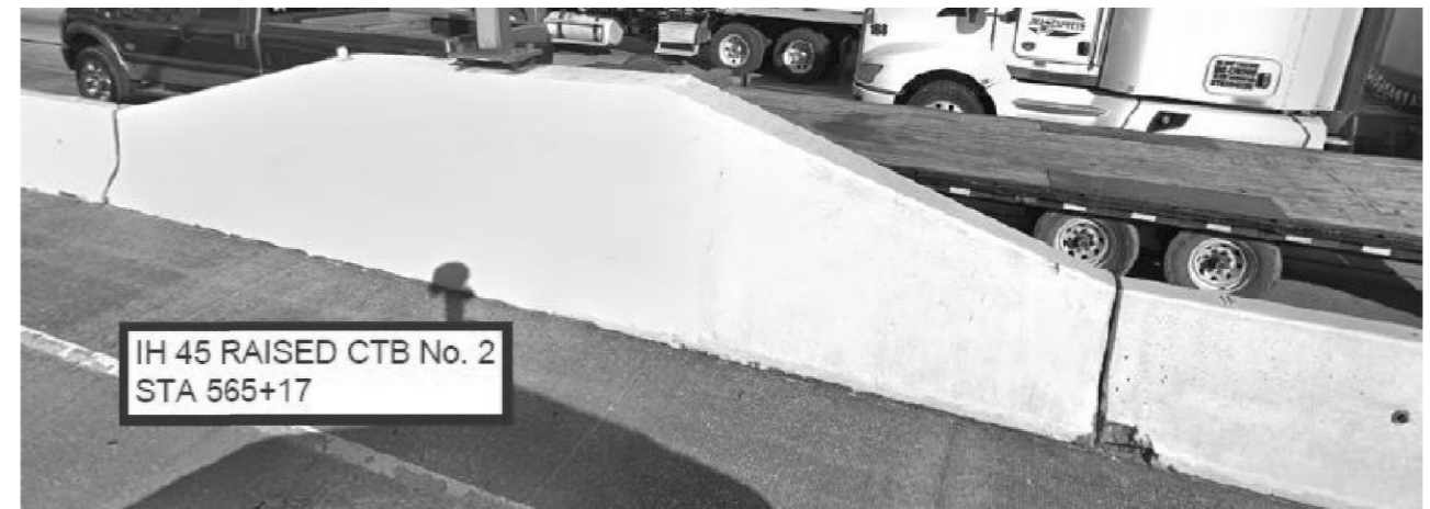
IH 45 RAISED CTB STA 565+17
