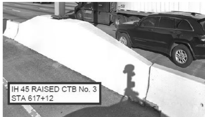
IH 45 RAISED CTB STA 617+12
