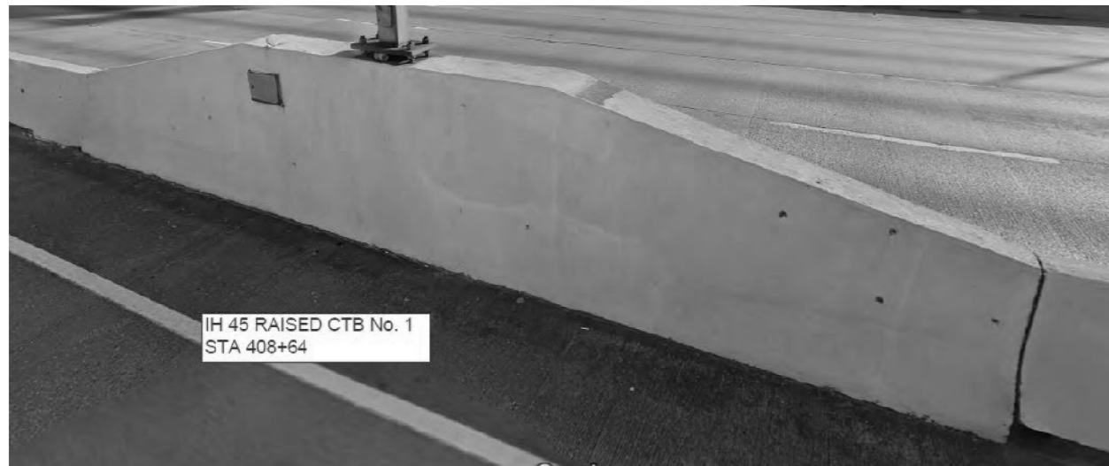
IH 45 RAISED CTB STA 408+64
